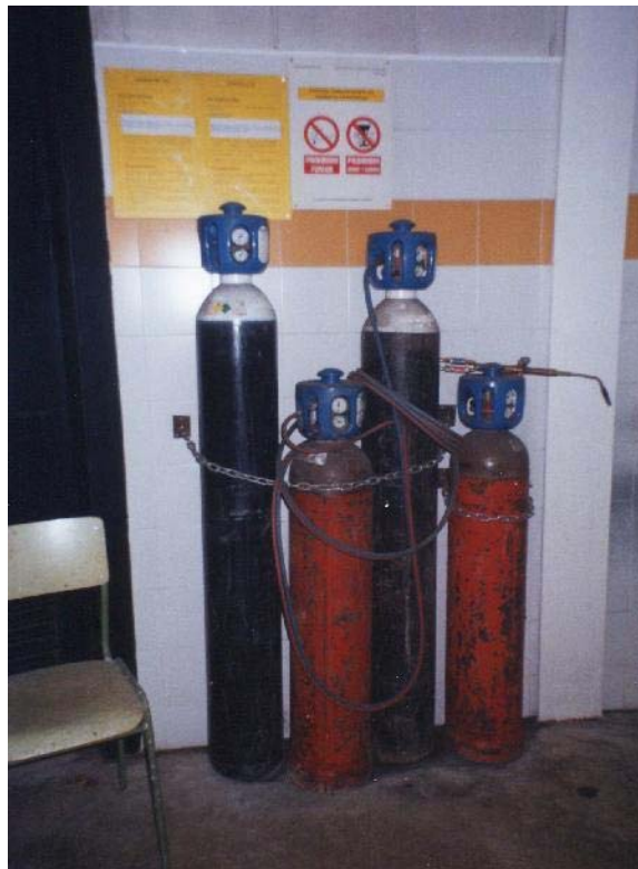
Figura 15. Equipo de soldadura autógena
